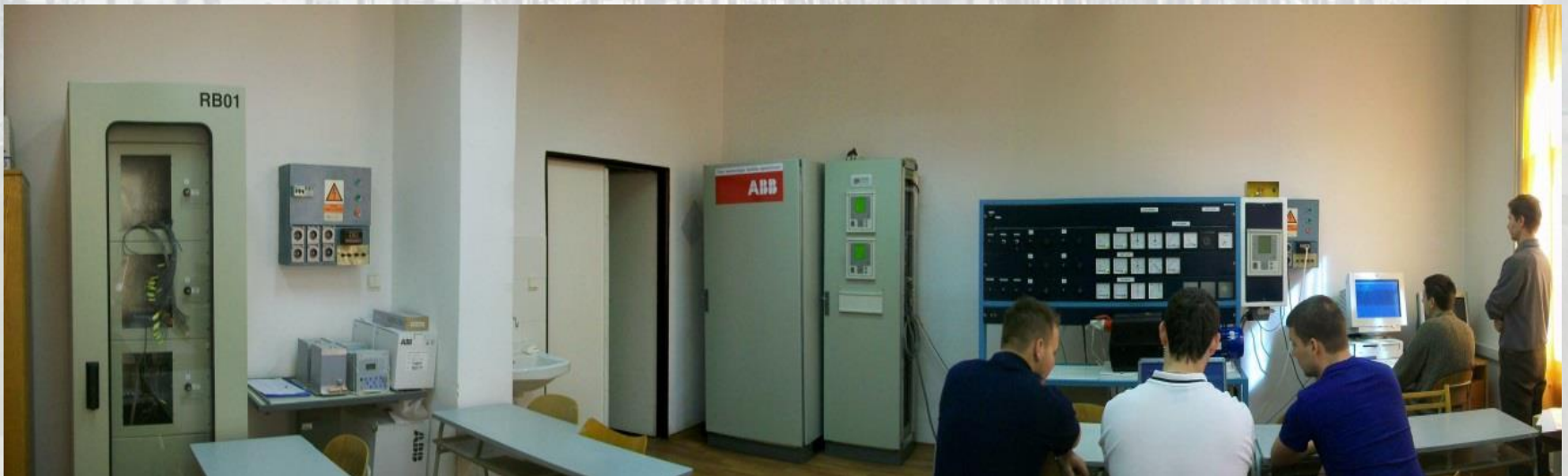
Laboratórium prevádzky elektrizačných sústav
